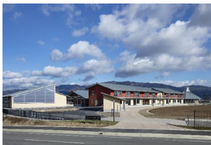
陸前高田市立気仙小学校新築工事
