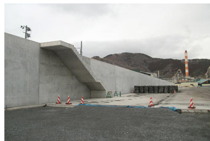
大船渡漁港海岸茶屋前災害復旧工事
