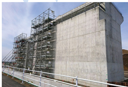
東北自動車道 4号ICに係る橋台躯体工事
