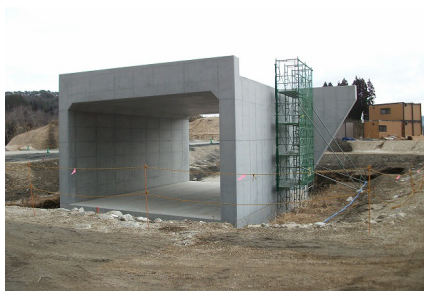
国道45号山田第2トンネル工事
