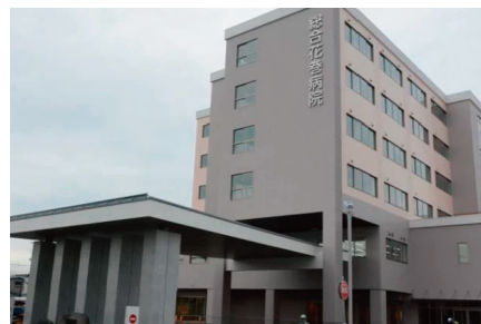
公益財団法人 総合花巻病院移転新築工事
