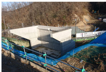
国道106号小山田道路地区工事
