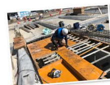
多賀城消防署の工事風景
